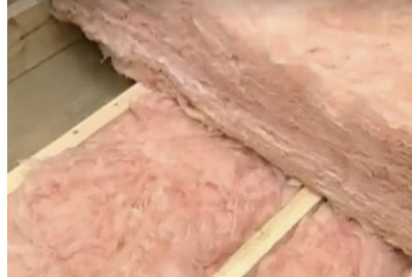
Պատկեր 29. Ձեղնահարկի ջերմամեկուսացման Քայլ 5-ի սխեմատիկ տեսքը
